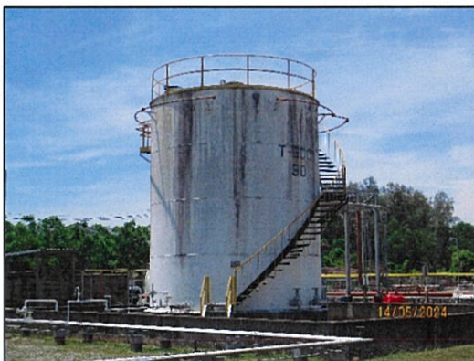
ภาพถ่ายที่ 2.2-8 ถังเก็บรวบรวมน้ำมันจากบ่อดักไขมัน (Slop Tank)
