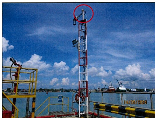
ภาพถ่ายที่ 2.2-13 การติดตั้งสัญญาณไฟกระพริบ บริเวณท่าเทียบเรือของโครงการ
