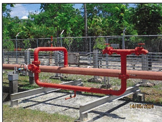
ภาพถ่ายที่ 2.2-19 การติดตั้งอุปกรณ์ป้องกันระงับเหตุอัคคีภัยและอุปกรณ์ล้างตาฉุกเฉิน ภายในบริเวณพื้นที่ปฏิบัติงานคลัง
