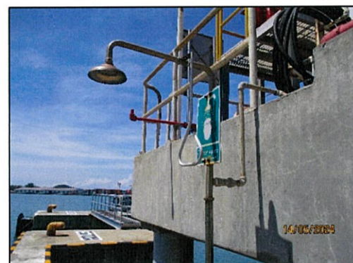
ภาพถ่ายที่ 2.2-20 การติดตั้งอุปกรณ์ป้องกันระงับเหตุอัคคีภัยและอุปกรณ์ล้างตาฉุกเฉิน ภายในบริเวณพื้นที่ทำแทียบเรือ
