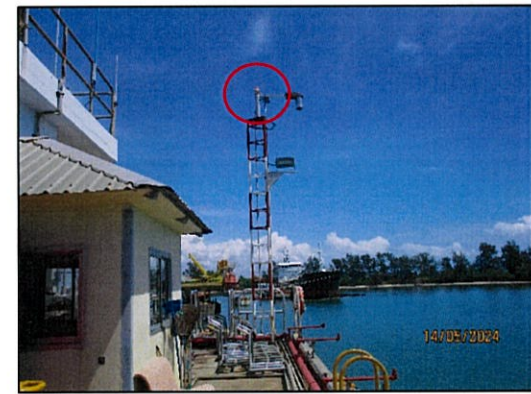
ภาพถ่ายที่ 2.2-13 การติดตั้งสัญญาณไฟกระพริบ บริเวณท่าเทียบเรือของโครงการ
