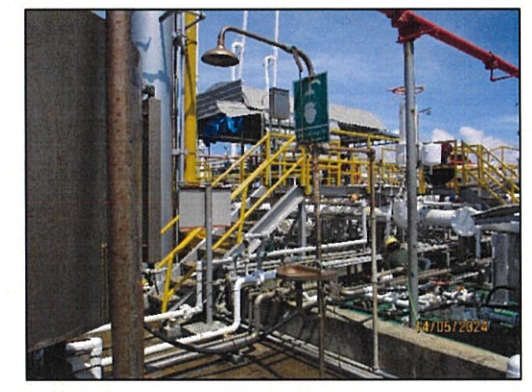
ภาพถ่ายที่ 2.2-19 การติดตั้งอุปกรณ์ป้องกันระงับเหตุอัคคีภัยและอุปกรณ์ล้างตาฉุกเฉิน ภายในบริเวณพื้นที่ปฏิบัติงานคลัง
