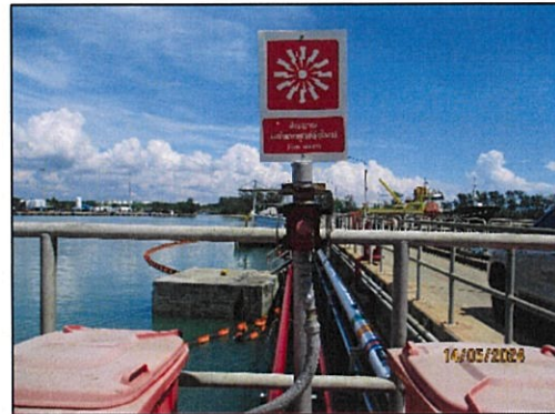
ภาพถ่ายที่ 2.2-21 การติดตั้งสัญญาณเตือนเหตุเพลิงไหม้บริเวณพื้นที่โครงการ
