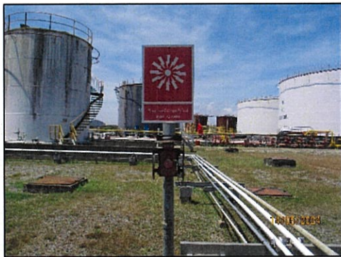
ภาพถ่ายที่ 2.2-21 การติดตั้งสัญญาณเตือนเหตุเพลิงไหม้บริเวณพื้นที่โครงการ
